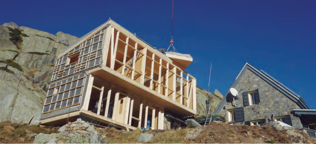
Ampliación del Refugi Ventosa i Calvell en el Parc Nacional d'Aigüestortes
